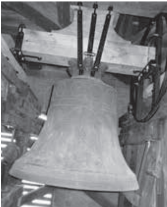
Links: Glocke 3 (1926) mit dem neuen Holzjoch. Rechts: Die neuen Klöppel werden eingebaut.
